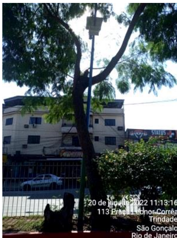
Figura 64 - Árvore em conflito com iluminação pública.
