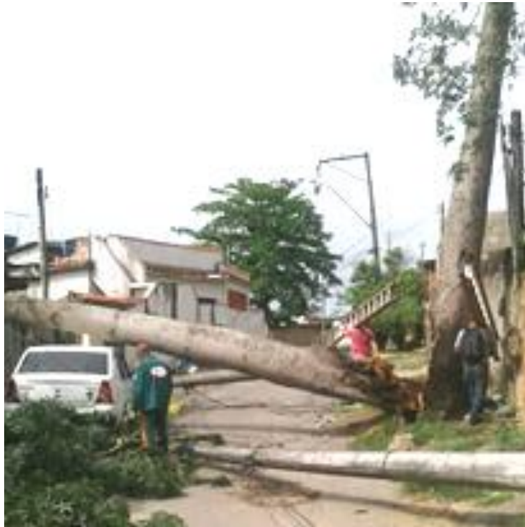
Figura 59 - Exemplo se situação emergencial.
