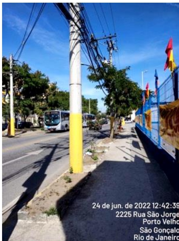
Figura 67 - Árvore em conflito com a rede aérea.
