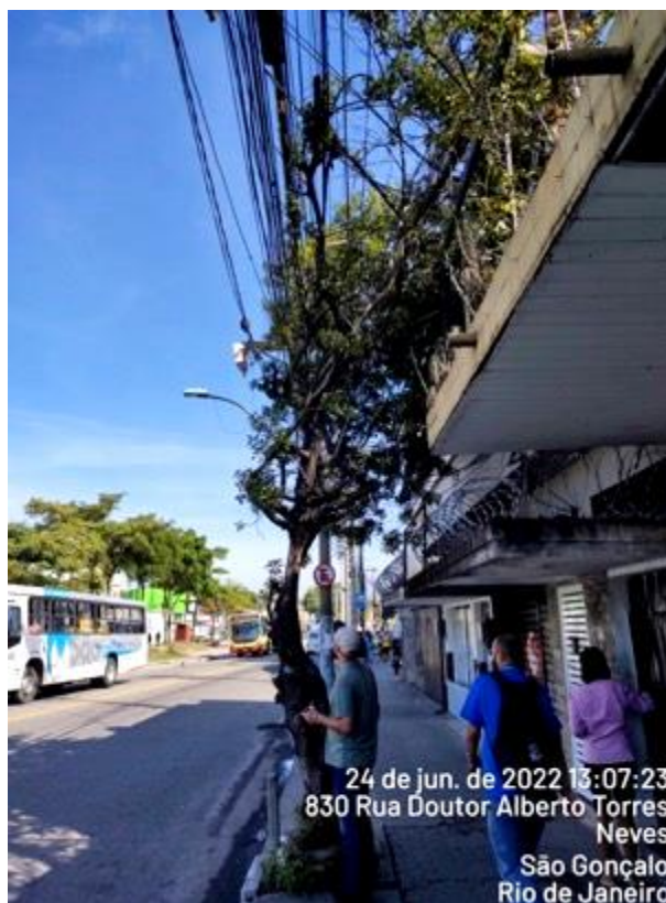
Figura 63 - Árvore em conflito com rede aérea e fachada.
