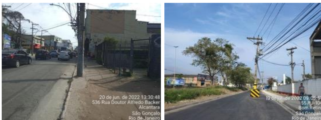
Figura 5 - Exemplo de falta de planejamento, com excesso de postes em ambos lados da via, calçadas sem padrão, fiação cruzando a caixa da rua.
