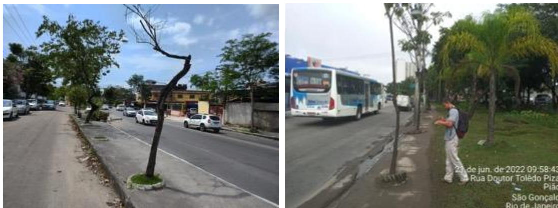
Figura 36 - Exemplos de substituição e gola inadequada.
