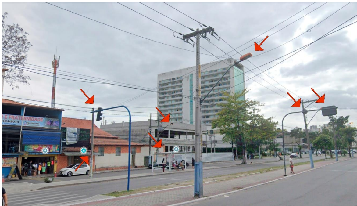
PONTO DE ÔNIBUS COM COBERTURA, POSTE DE ILUMINAÇÃO, SEMAFORO COM E SEM TEMPORIZADOR E PLACA DE SINALIZAÇÃO.
