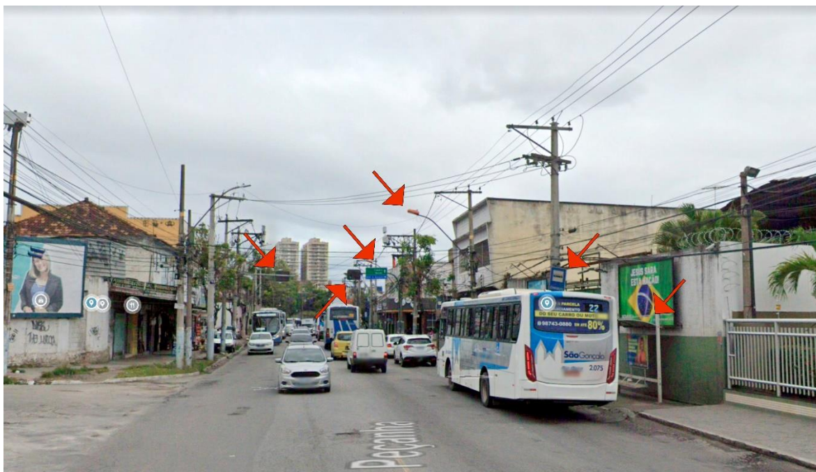
PONTO DE ÔNIBUS COM COBERTURA, POSTE DE ILUMINAÇÃO, SEMAFORO COM TEMPORIZADOR E PLACAS DE TRÂNSITO
