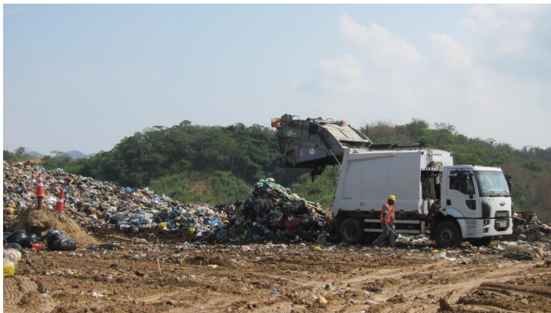
Figura 69 – Detalhe do descarregamento de resíduos na célula de operação.
