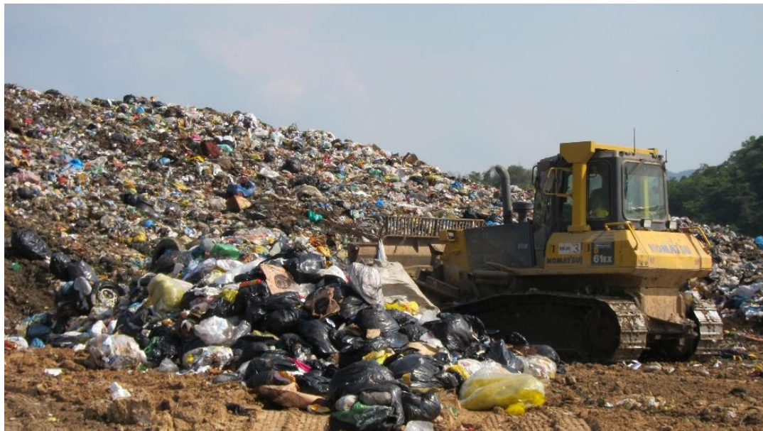
Figura 71 – Compactação dos resíduos na célula de operação.
