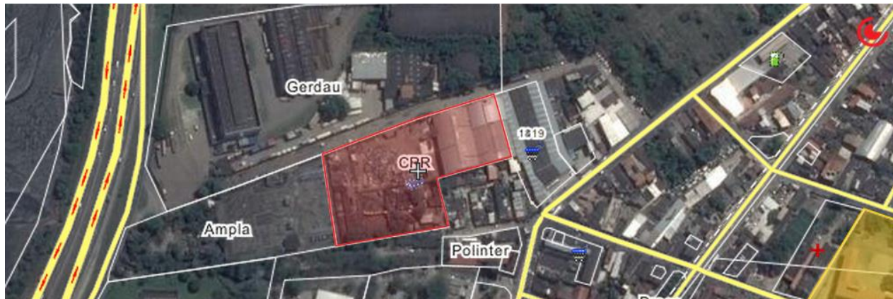
Figura 53 – Galpão localizado na rua Barão de São Gonçalo, no município de São Gonçalo, com aproximadamente 3.000 m 2 de área.
