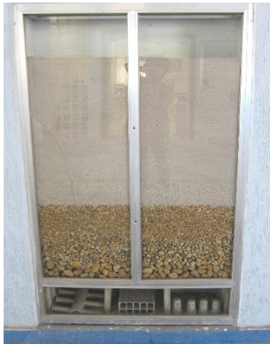
Figura 32 – Corte exemplificativo dos Filtros da ETA.
