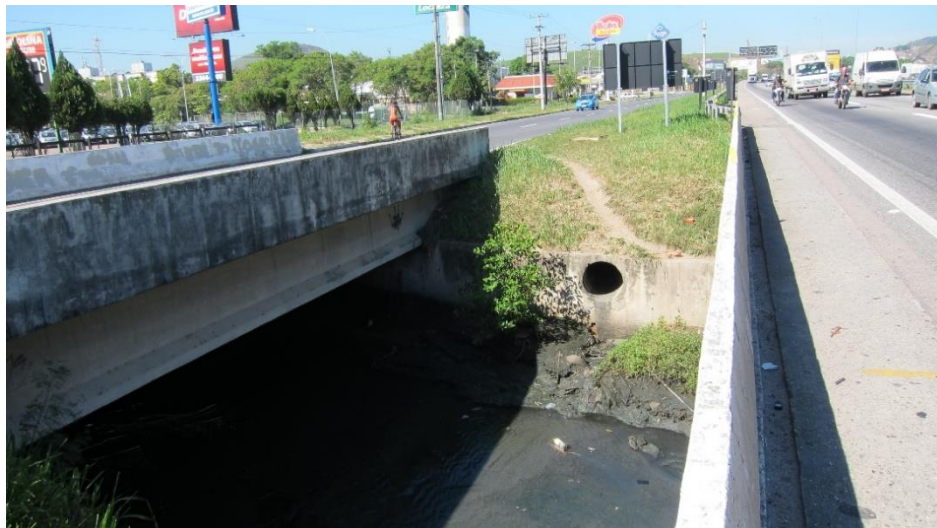
Figura 34 – Rio Bomba (travessia na BR 101).
