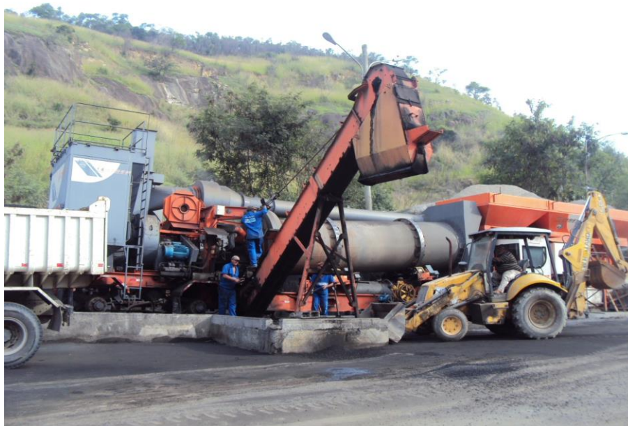
Figura 75 – Usina móvel de asfalto em funcionamento.
