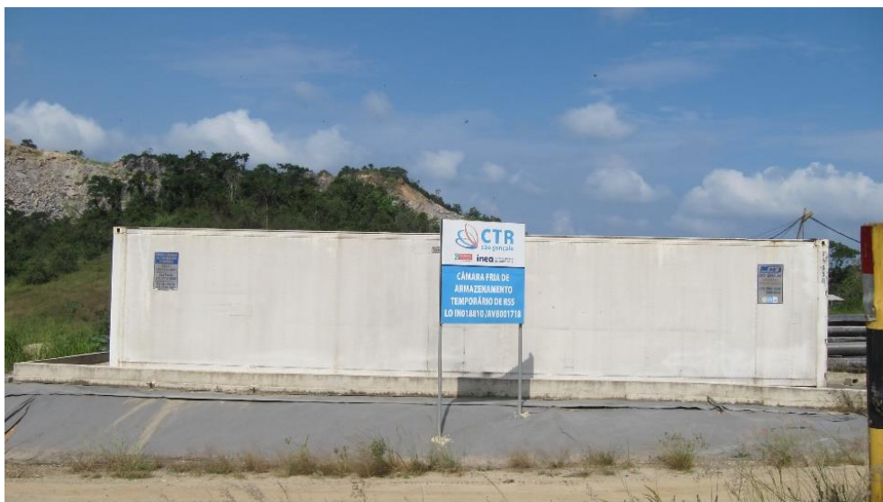
Figura 60 – Câmara fria para armazenamento temporário dos RSS na CTR-Alcântara.
