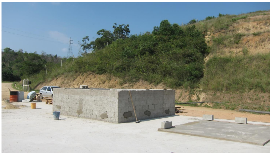
Figura 74 – Preparação do local para receber a estrutura da ETC.
