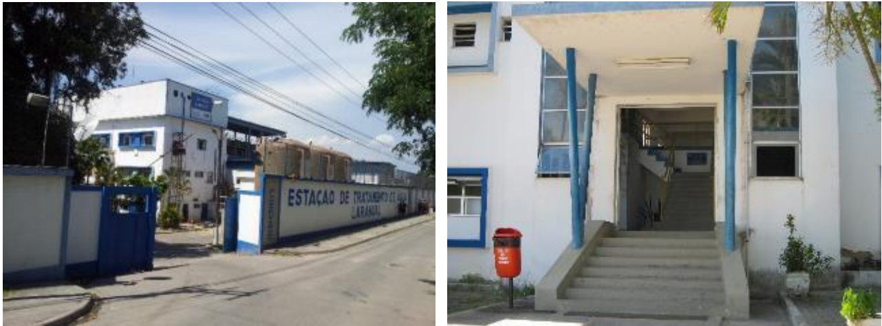
Figura 25 – Acesso a Estação de Tratamento Sistema Imunana – Laranjal.
