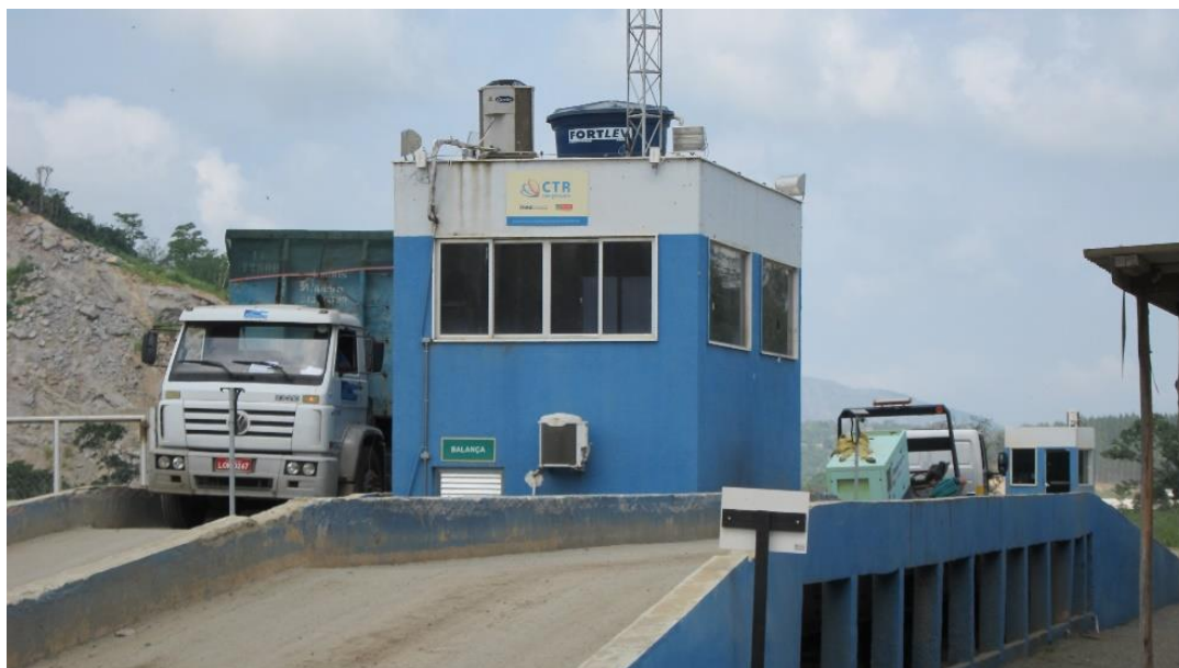
Figura 72 – Detalhe da balança, localizada na entrada da CTR.
